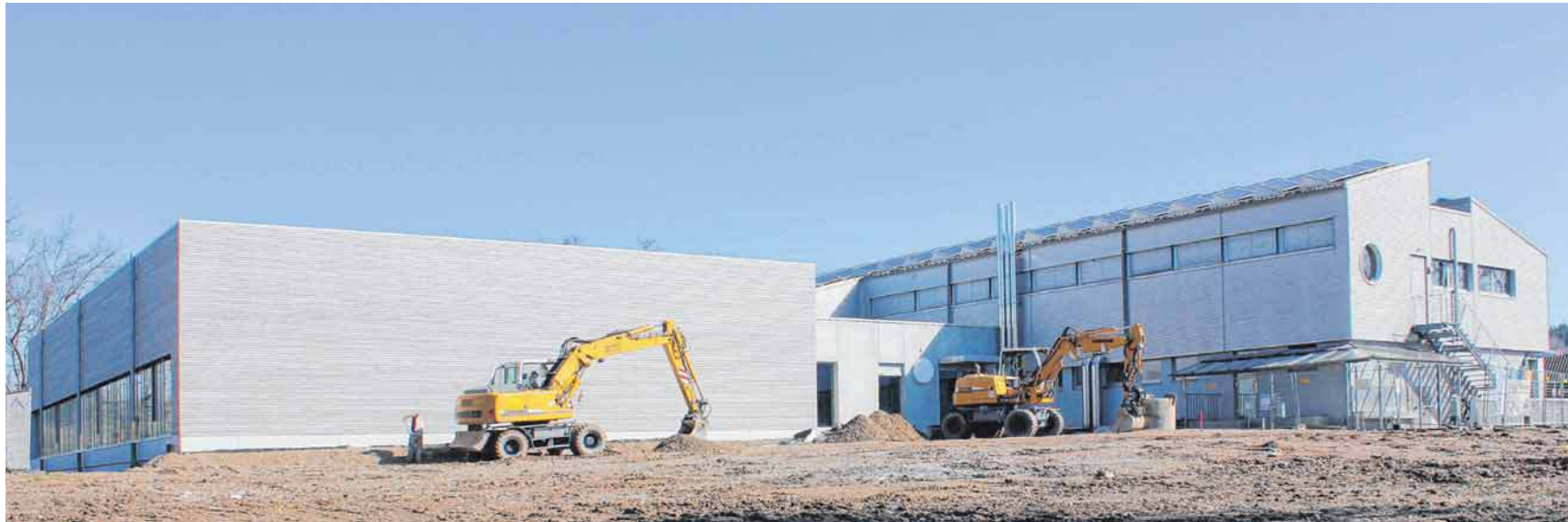
Drei Meter tief im Erdreich befindet sich die neue Sporthalle (links). Ein Zwischenbau verbindet sie mit dem bestehenden Gebäude (rechts). FOTOS: RUTH EBERHARDT
