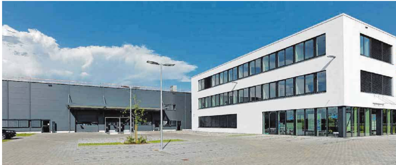
In der Otto-Lilienthalstraße in Friedrichshafen ist mit dem neuen Firmensitz ein markanter Neubau entstanden.
